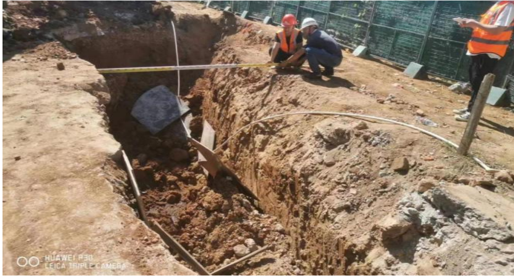
图 3 事故段沟槽开挖
