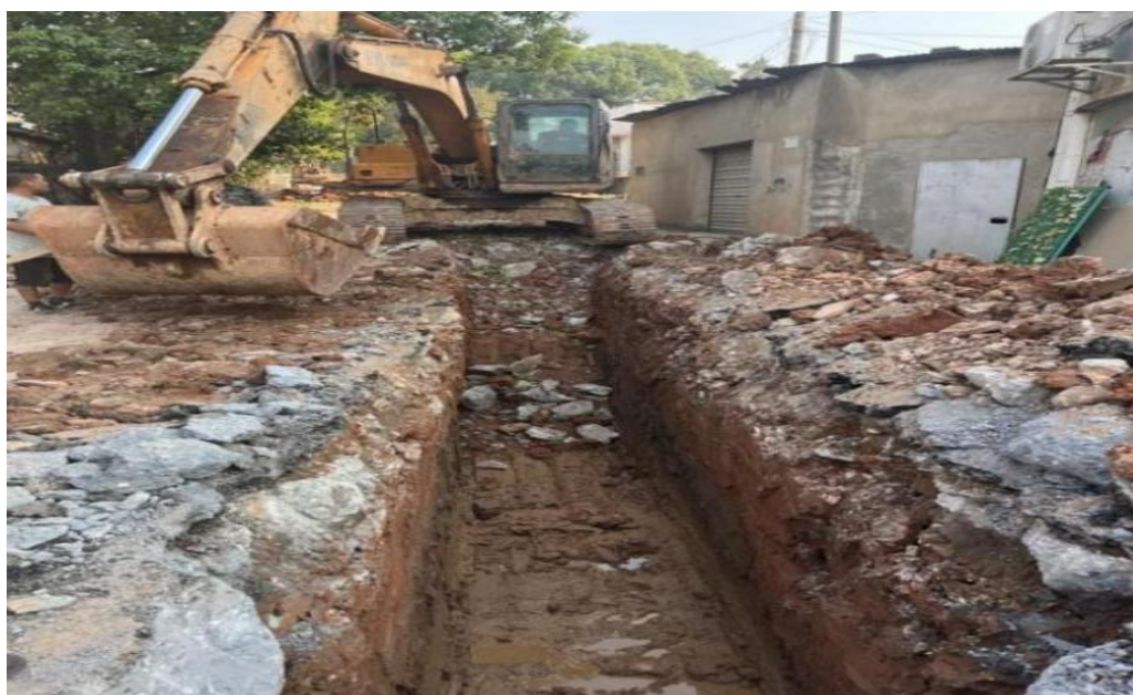
图 2 沟槽已经入地下水位以下
